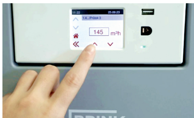
Přesné nastavení větrací jednotky Brink Flair
