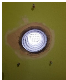
Průměr potrubí dle množství přiváděného vzduchu
