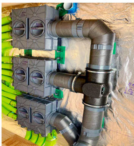
Napojení AE s rozdělovacími DBoxy na zónovou regulaci
