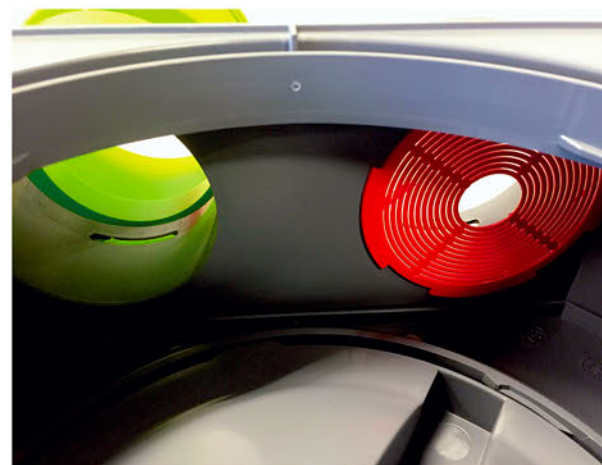
Regulační clony v DBoxu pro přesné nastavení průtoku vzduchu
