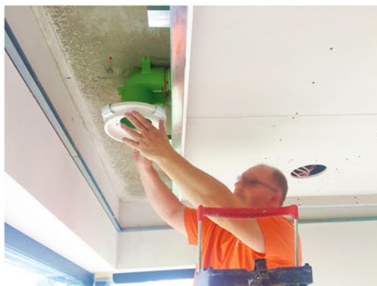
Sádrové přívodní prvky Ventmann lze nechat splynout s povrchem stropu a přetřít barvou.
