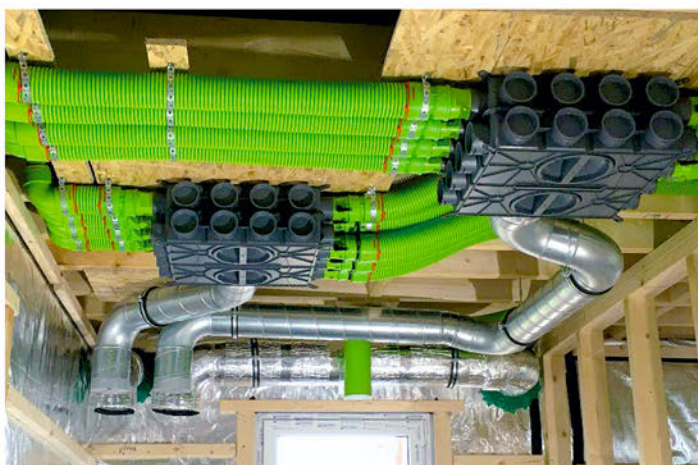
Profesionální příprava vzduchotechnického rozvodu AE v dřevostavbě
