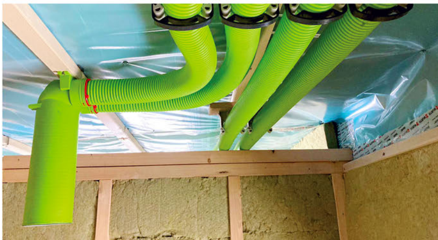
Instalace AE pod tepelnou izolací a parotěsnou fólií
