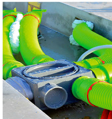
Instalace AE v betonovém monolitickém stropu
