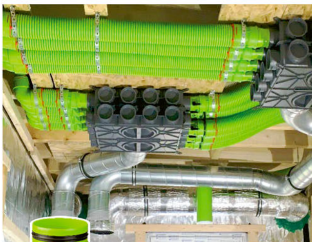
Profesionální instalace s rozdělovacím boxem DBox Air Excellent osazeným regulačními klapkami
