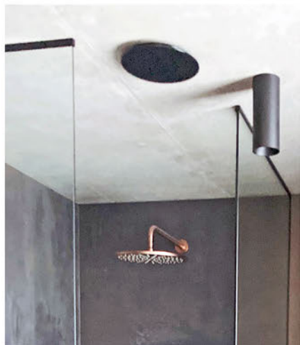
Pohledový beton s osazeným přívodním ventilem.
