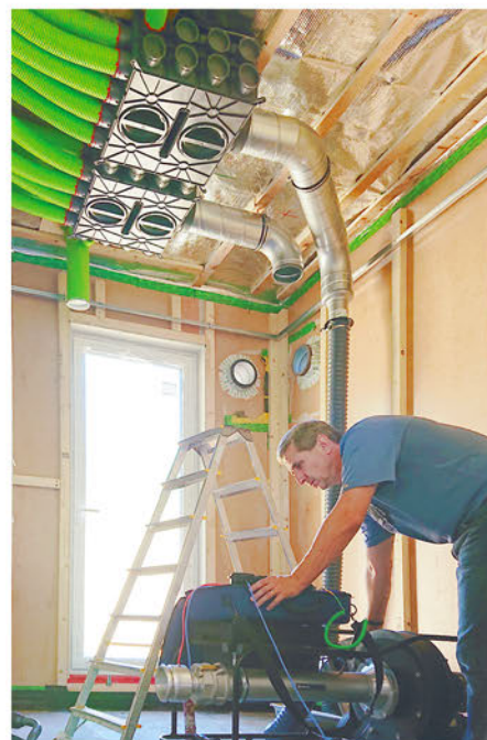
Ověřování těsnosti na stavbě pomocí přístroje P.A.N.D.A. Airflow.
