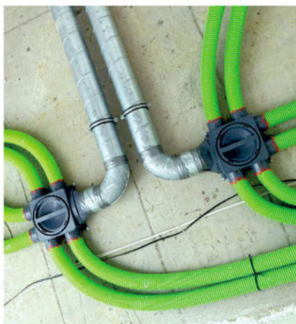
Instalace AE s nízkými rozvodnými DBoxy pod strop do podhledu s minimálním snížením stropu
