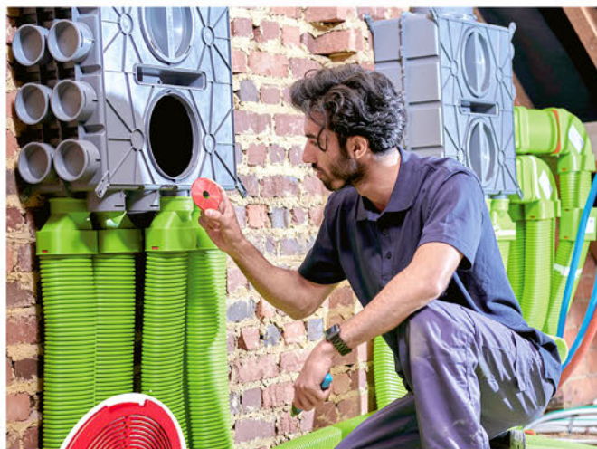
Použití regulačních clon, které jsou součástí dodávky DBoxů Air Excellent
