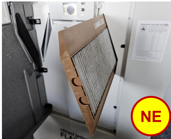
Neoriginální filtr od firmy RUCATECH má oproti originálnímu filtru BRINK více než 3x vyšší odpor.
