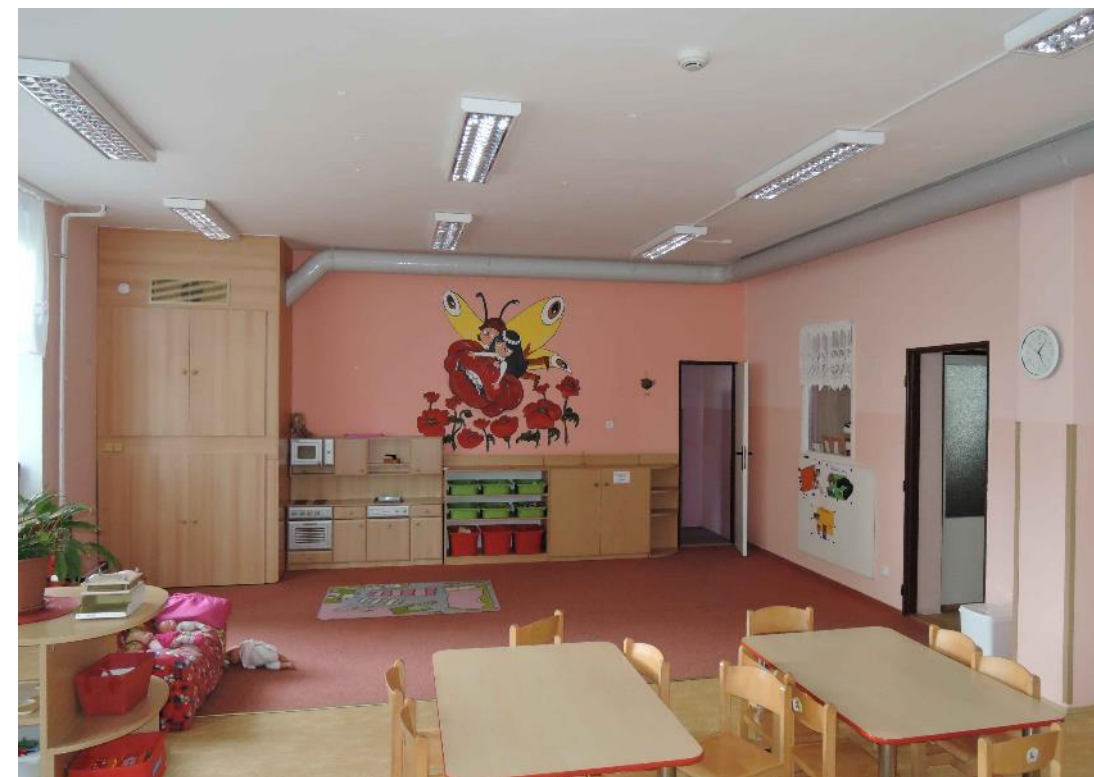
Opláštění větracích jednotek je identické s nábytkem ve třídě a část skříňě větrací jednotky slouží jako úložný prostor. Větrací jednotky s dostatečnou rezervou splňují hlukové limity.
