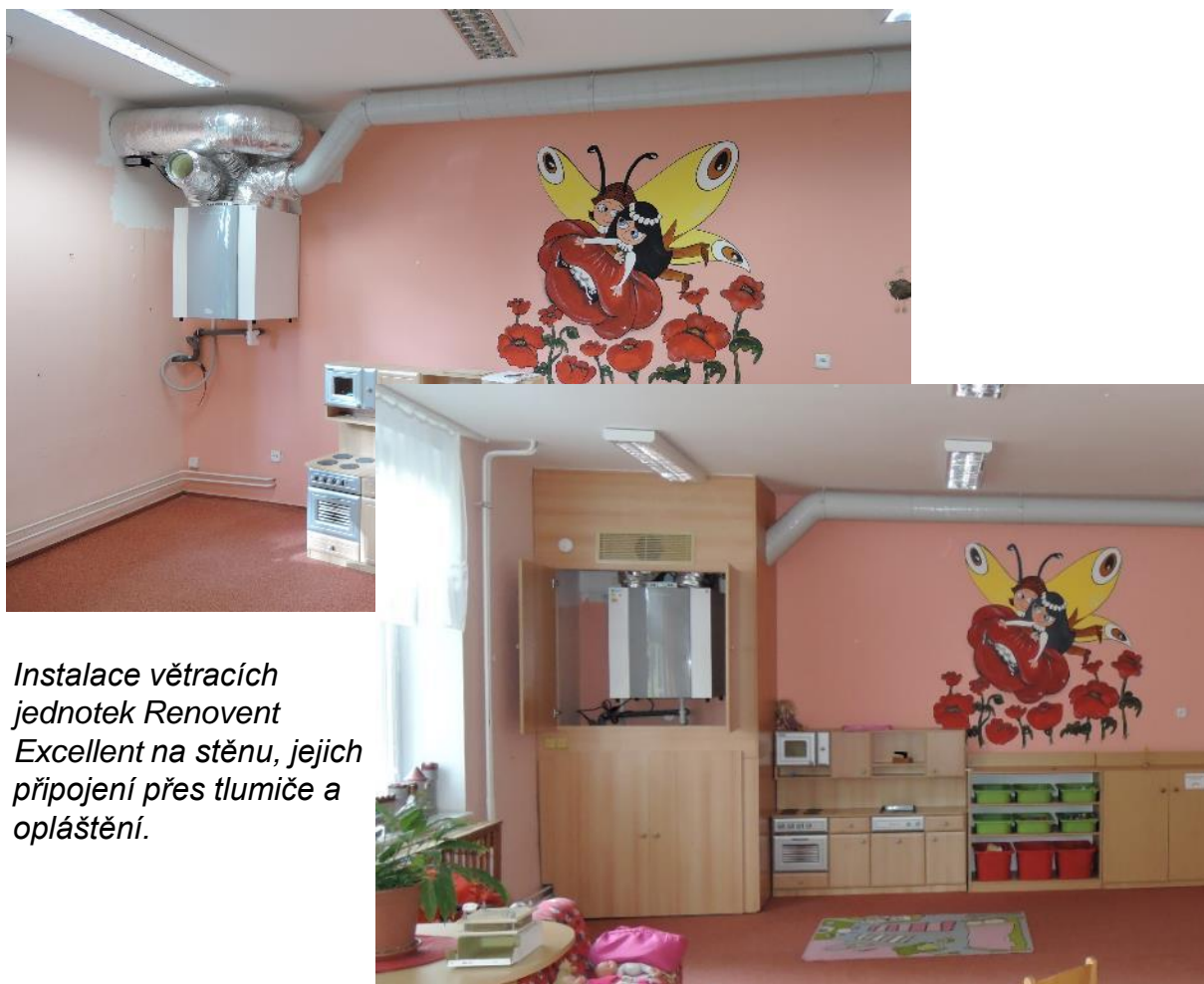
Opláštění větracích jednotek je identické s nábytkem ve třídě a část skříňě větrací jednotky slouží jako úložný prostor. Větrací jednotky s dostatečnou rezervou splňují hlukové limity.
